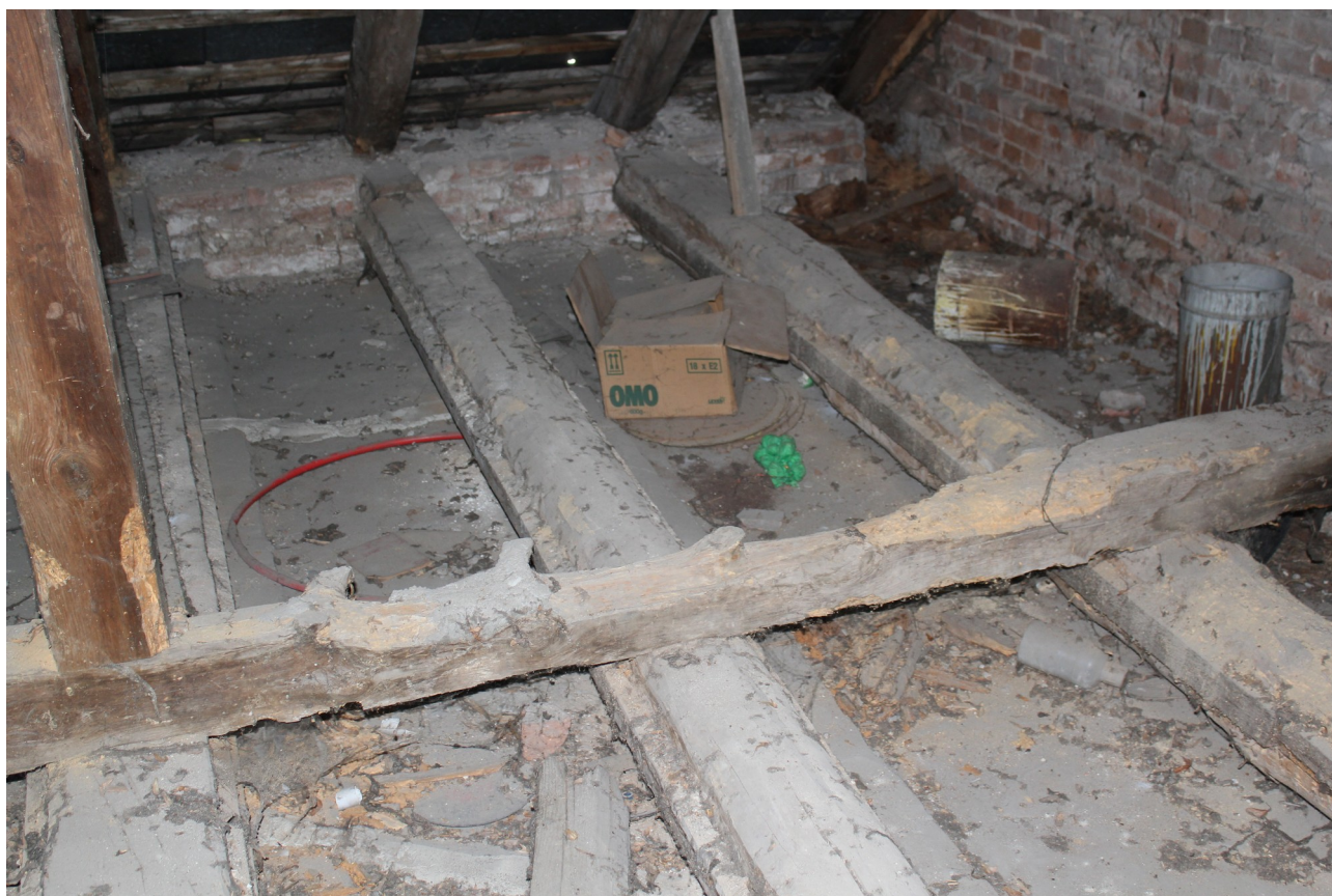
Fot. 25. Degradacja elementów więźby.
