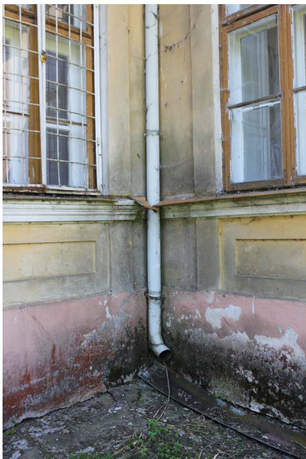
Fot. 3 i 4. Elewacja frontowa, widoczne skutki zawilgocenia.
