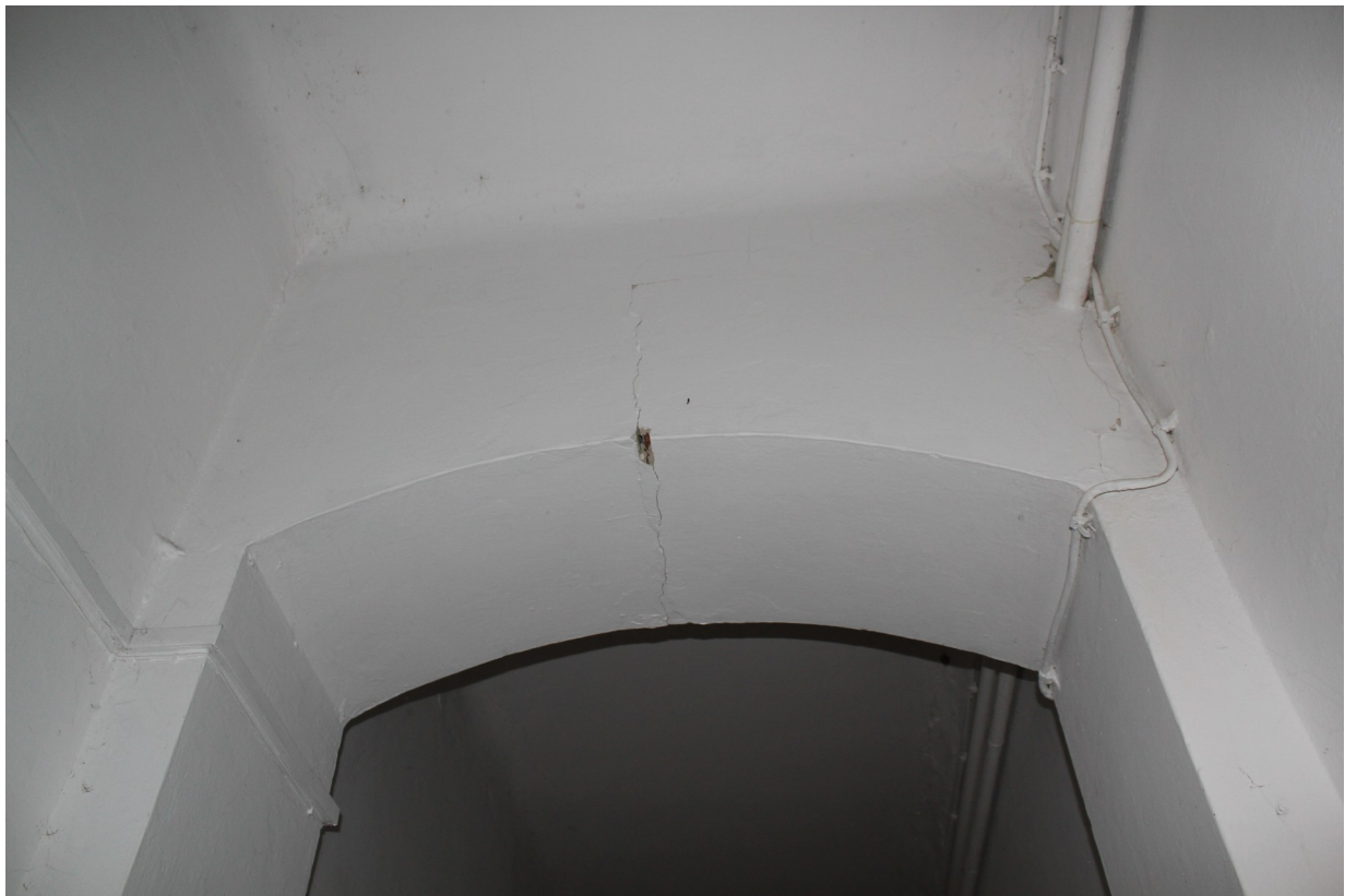
Fot. 36. Pęknięcie nadproża.
