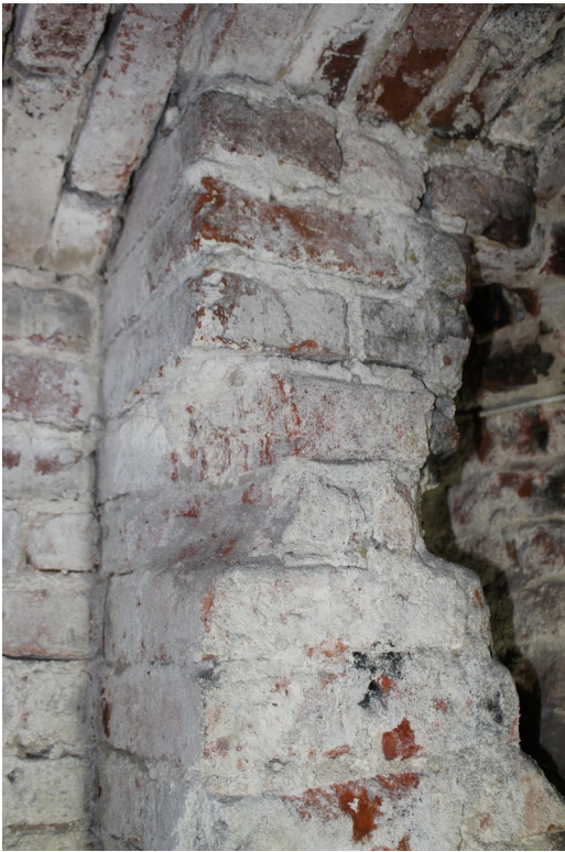
Fot. 19 i 20. Piwnica, ściany pokryte wysoleniami.
