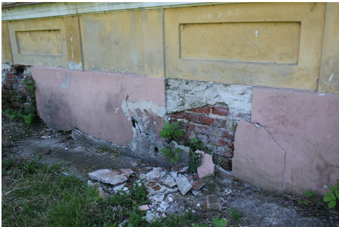
Fot. 6. Elewacja, cokół, stan zachowania wypraw tynkarskich i muru.
