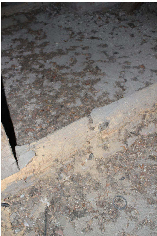
Fot. 23 i 24. Widoczna degradacja elementów więźby.
