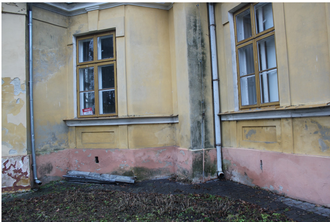
Fot. 16. Okolice portyku, skutki zawilgocenia wilgocią kapilarną i wodą opadową.
