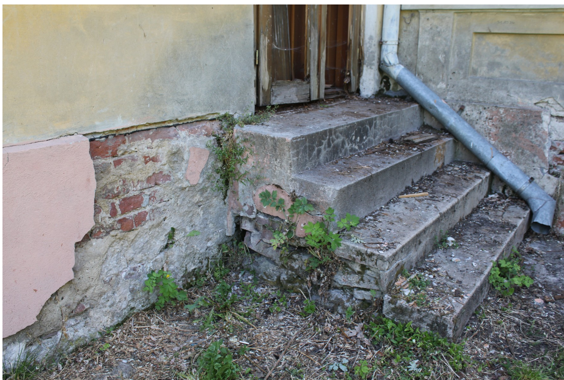
Fot. 7. Strefa cokołowa, stan zachowania muru widoczny w ubytku.
