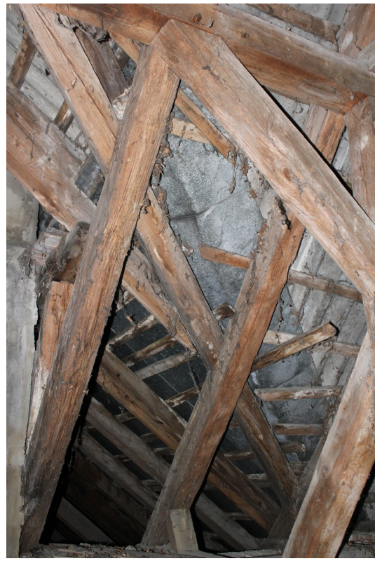
Fot. 21 i 22. Więźba, widoczne uszkodzenia i korozja biologiczna.
