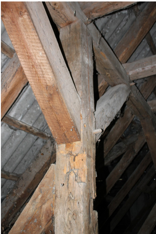
Fot. 21 i 22. Więźba, widoczne uszkodzenia i korozja biologiczna.
