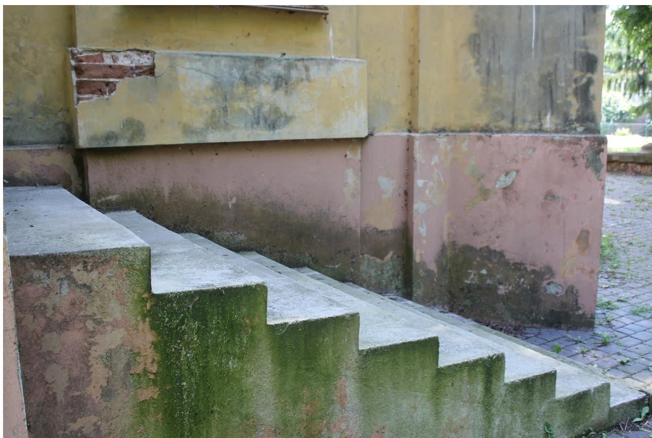
Fot. 5. Schody zewnętrzne, widoczne ubytki i skutki zawilgocenia.
