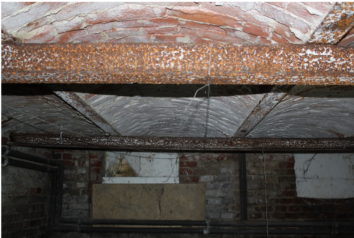
Fot. 17. Piwnica, strop odcinkowy, widoczna korozja belki.
