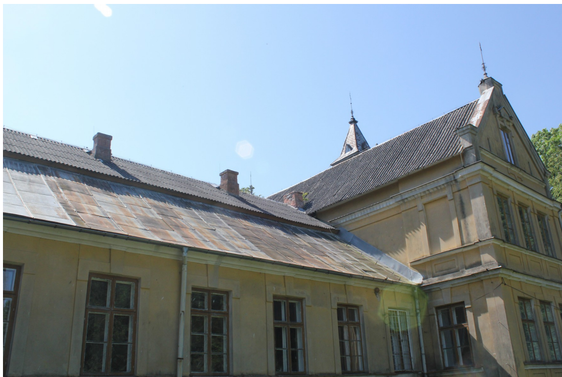
Fot. 11. Dach, częściowo z blachy, częściowo z azbestu.
