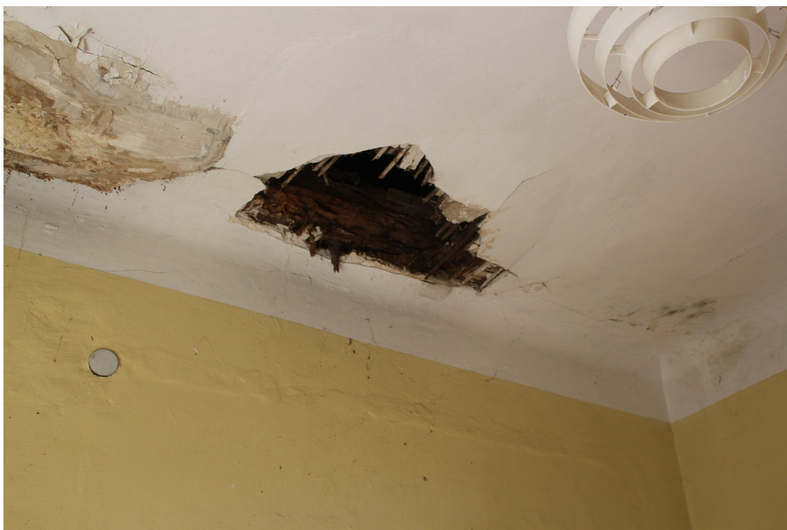
Fot. 29. Degradacja tynkowanej podsufitki.
