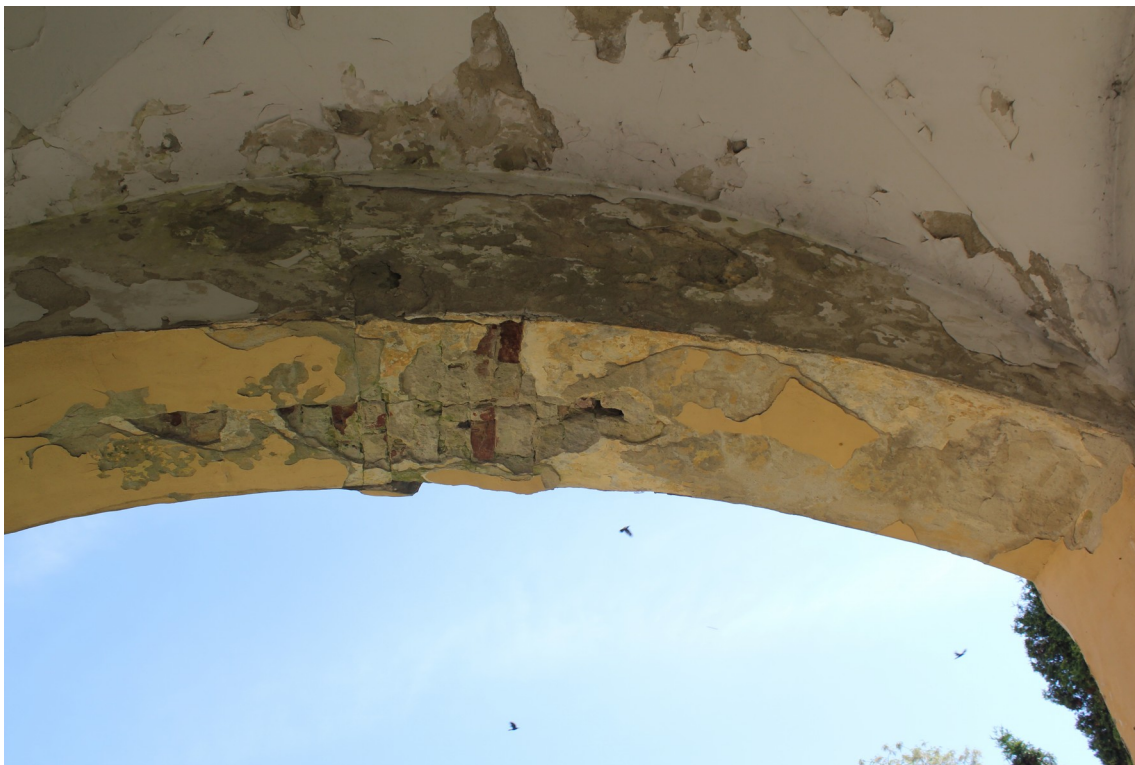
Fot. 10. Portyk wejściowy, pęknięcie łuku nadproża.
